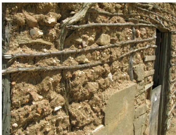
Parede de casa de taipa: detalhe do trançado de varas. Campo Grande/RN. Fonte: Ítégra Pesquisa e Consultoria, 2009
